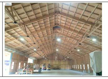
天井スケルトンでのイメージも 温かみが加わり大きく変わりま す。鉄骨造の場合での塗装メン テナンスが不要にもなります。
